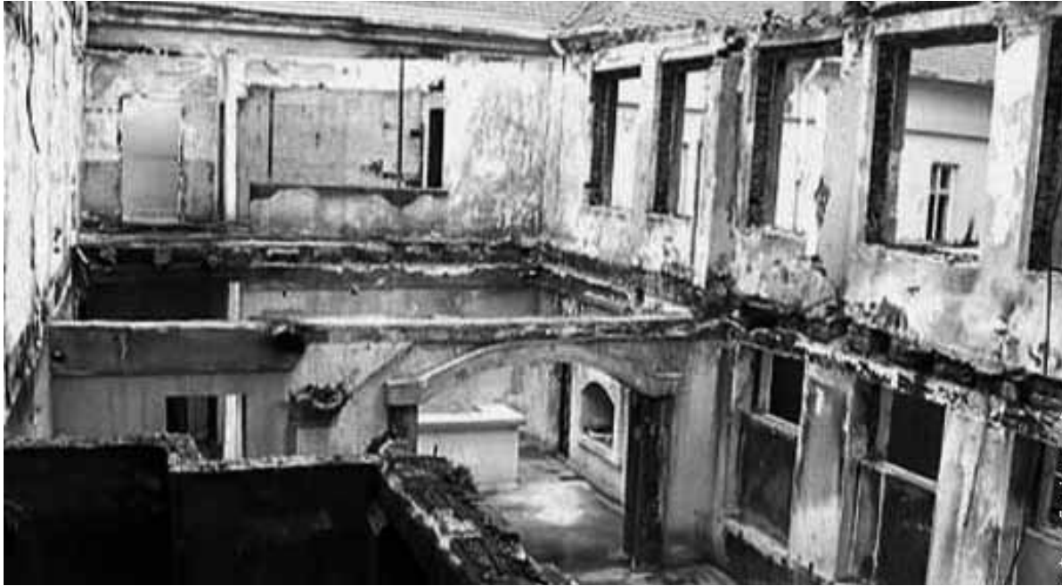
Pozorište „Bora Stanković“ posle požara
